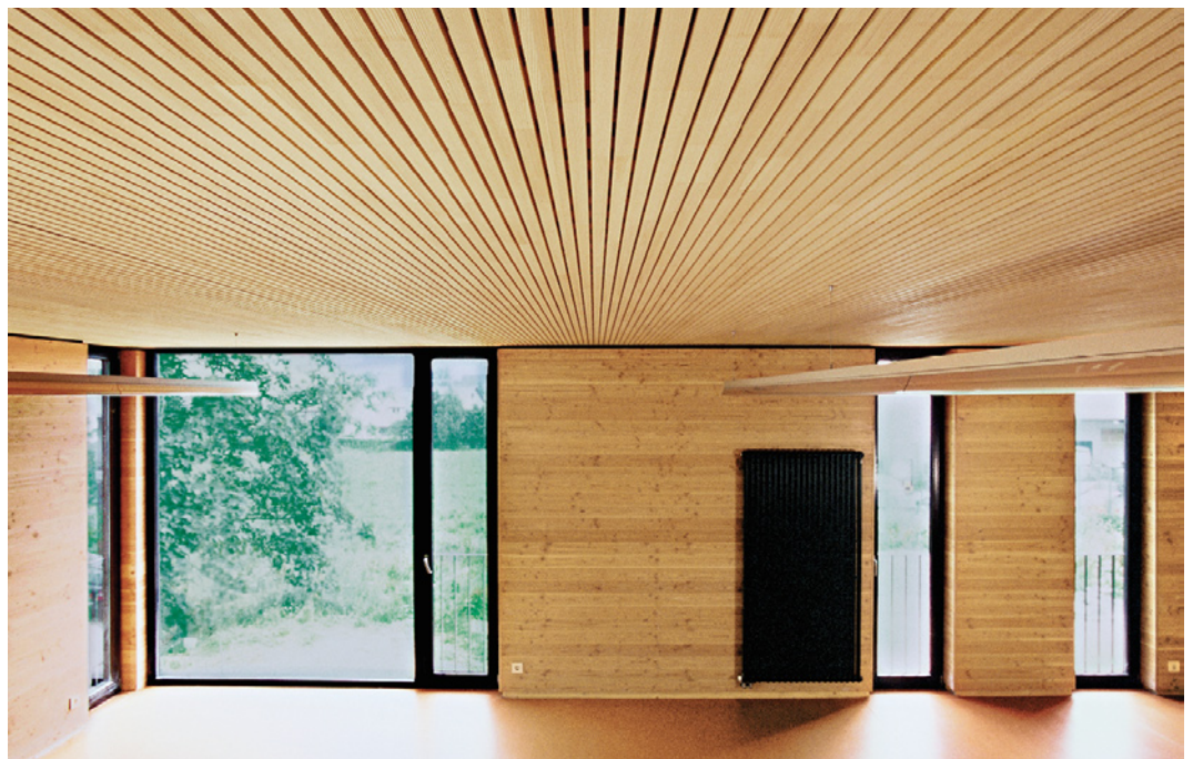
Abb. 4.6 Tragende Akustikdecke mit Elementuntersicht in astreinem Weißtannenholz (Kinderhaus Ludwigsburg, Dip.-Ing. Freier Architekt BDA Kai Dongus, Ludwigsburg)
