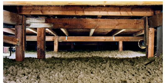
Abb. 3.8 Belüftetes Flachdach, gleichmäßig gedämmt mit Steinwollegranulat
