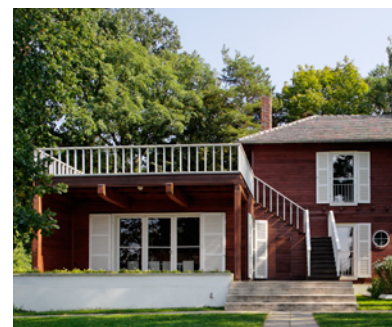
Abb. 1.1 Dachterrasse des Einsteinhauses in Caputh
